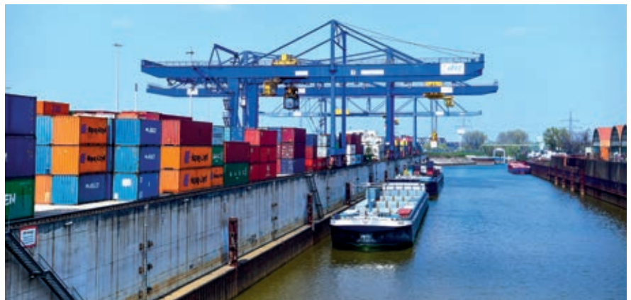
Duisburger Innenhafen: Containerumschlag 2019 von ca. 4,0 Mio. TEU
